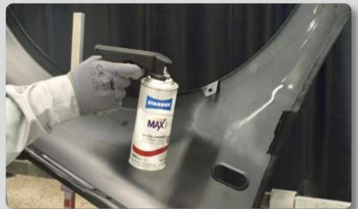
3. Standox 1K-Füllprimer auftragen
